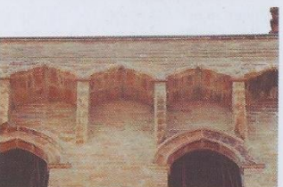
Via Carri, 12 Tipo I - Cornice a beccatelli
