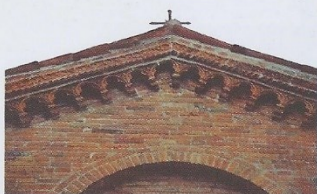
Via Camposabbionaro, 1 Chiesa di Santa Libera Tipo B - Cornice ad archetti
