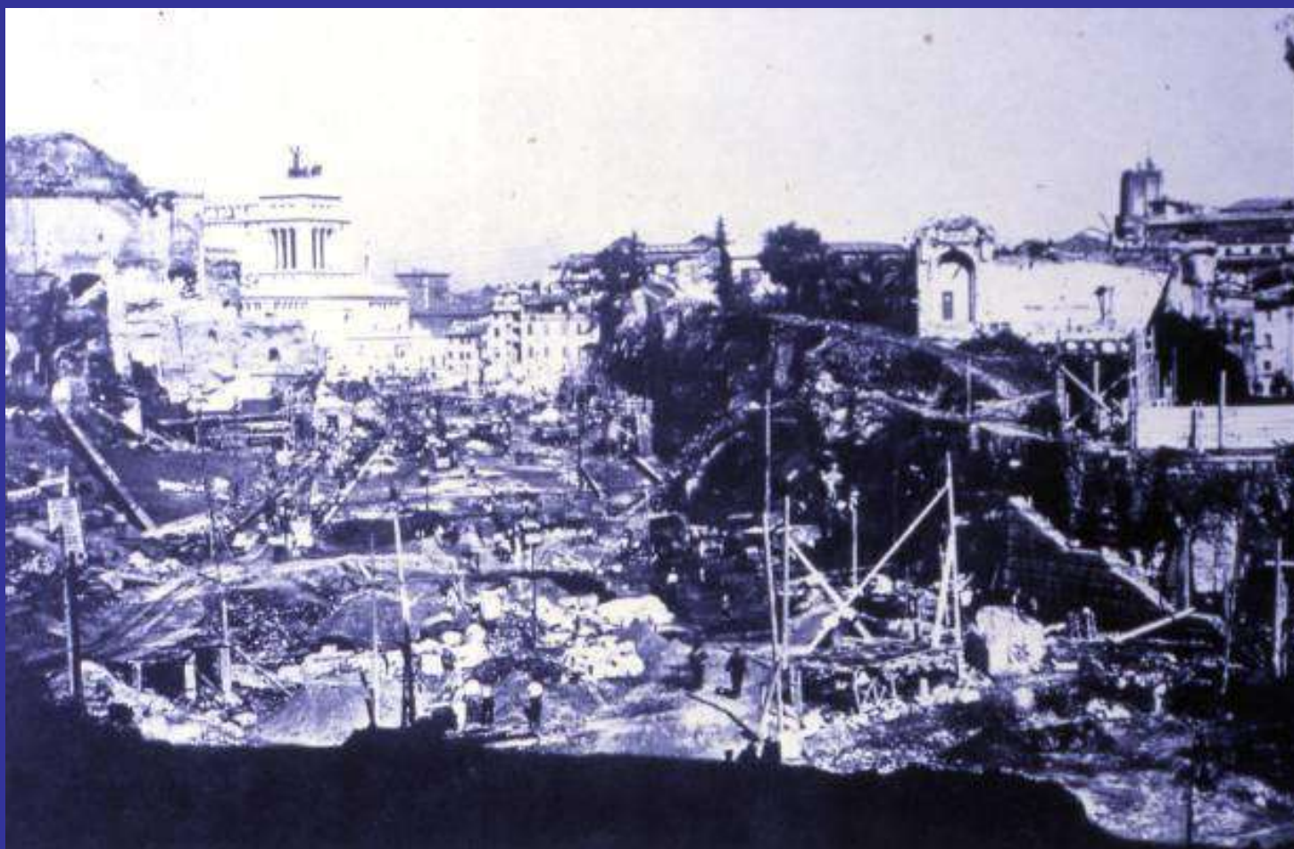
Le demolizioni per Via dell'Impero a Roma
