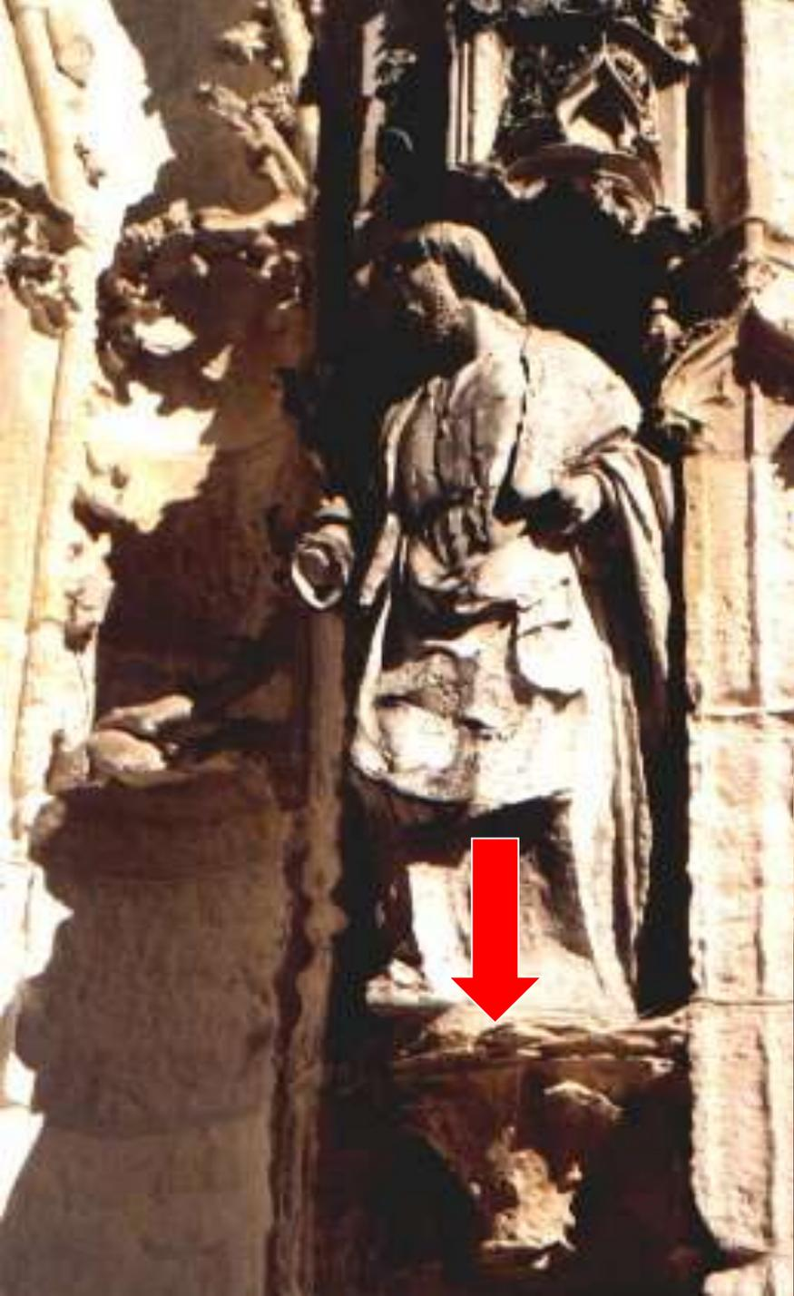
In questo caso è stato utilizzato un filo elettrico con una corrente di bassa intensità che passa nel filo alla base della statua.
