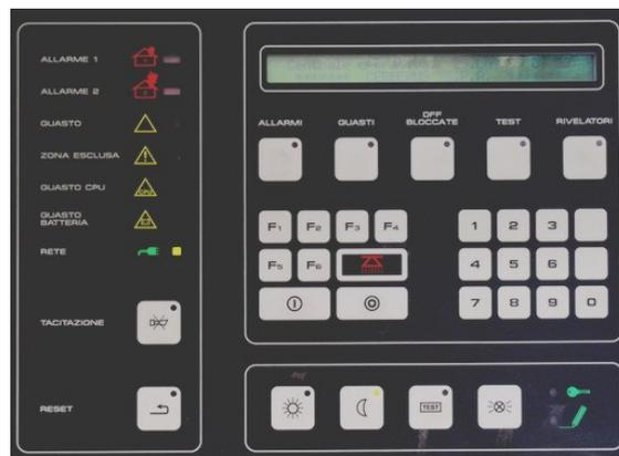
Nel fabbricato è attivo un sistema di allarme-rilevazione incendio, gestito da una centralina installata al piano terra, adiacente la portineria, dotato di segnalatori ottico-acustici ai vari piani; tale dispositivo è collegato per mezzo di un ponte radio bidirezionale al servizio di vigilanza attivo 24 h su 24h che consente di avvisare tutti gli occupanti di un eventuale pericolo, utilizzando un sistema di diffusione vocale distribuito in tutti i locali del fabbricato.
