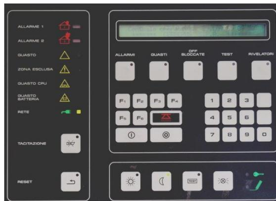
Nel fabbricato è attivo un sistema di allarme-rilevazione incendio, gestito da una centralina installata al piano terra, adiacente la portineria, dotato di segnalatori ottico-acustici ai vari piani; tale dispositivo è collegato per mezzo di un ponte radio bidirezionale al servizio di vigilanza attivo 24 h
