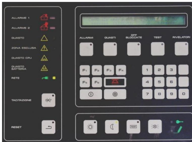
In caso di falso allarme il Vigile esegue sul pannello comandi della centrale le seguenti operazioni per tacitare le sirene e ripristinare l'impianto:
