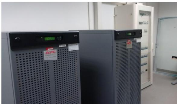
I due UPS derivano l'alimentazione dal teleruttore posizionato presso la stanza del quadro elettrico generale e alimentano oltre alle due sale server anche la quasi totalità delle prese elettriche posizionate nella stessa ala.
