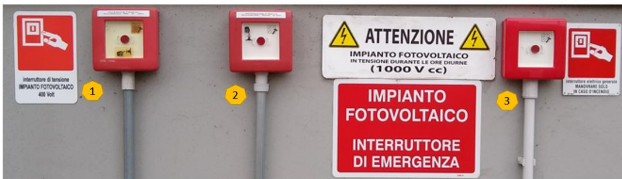
FOTOVOLTAICO SGANCIO 400 V.AC
