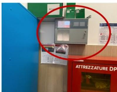
La centrale di rivelazione incendi del CORPO NORD è ubicata nel locale PTB.E32.PTE.T41 (piano terra, corridoio, sulla sinistra entrando da C.so Porta Mare, 2). Il sistema di rivelazione incendi si allarma tramite pulsanti manuali antincendio e sensori ottici di fumo automatici.
