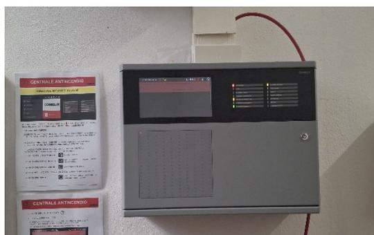
La centrale di rivelazione incendi del CORPO SUD è ubicata nel locale PTB.E32.PTE.T05 (piano terra, portineria, sulla destra entrando da C.so Ercole I D'Este, 32). Il sistema di rivelazione incendi si allarma tramite pulsanti manuali antincendio e sensori ottici di fumo automatici.
