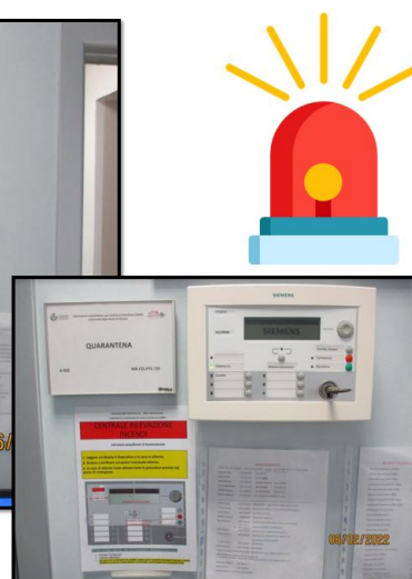
RIPETITORE ALLARME INCENDIO
