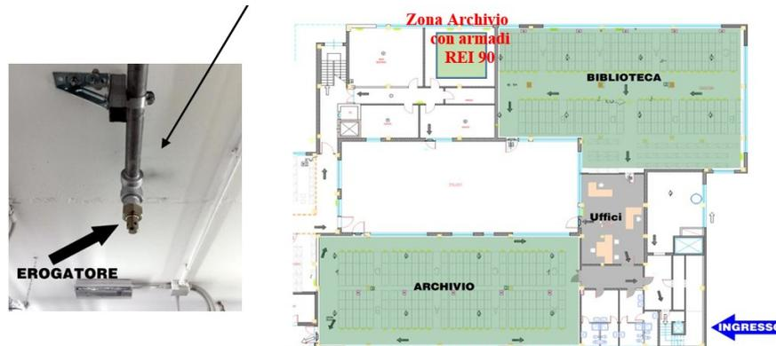
Lo spegnimento avviene mediante saturazione dell'atmosfera con l'Argon che, riducendo la concentrazione dell'ossigeno, impedisce la combustione.
