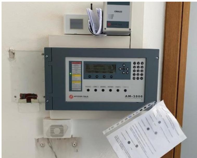
È posizionata all'interno della portineria, sono presenti a lato della centrale le planimetrie con indicazione di sensori e zona utili per identificare l'eventuale area interessata da emergenza. In caso di allarme la centrale indicherà il codice del sensore scattato, identificabile in planimetria.
