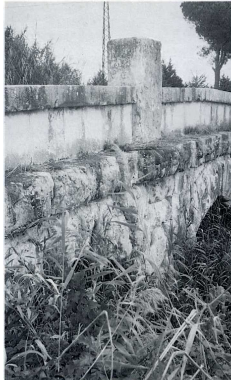
Fig. 19. Le pont de Treponti. Vue extérieure, prise du sud-ouest.
