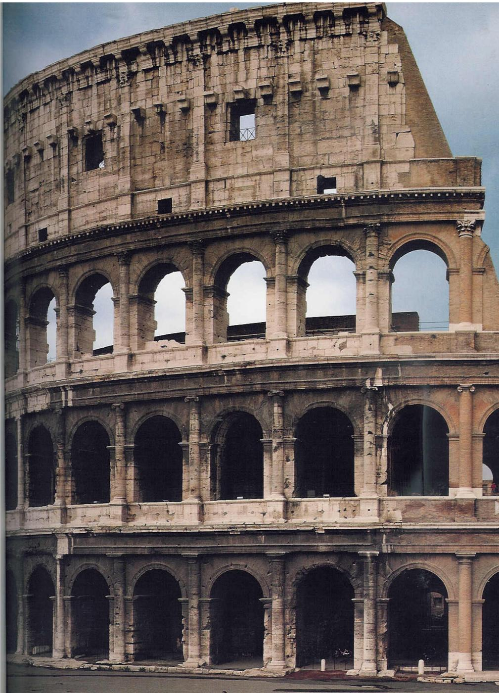
Esternamente la costruzione si sviluppava secondo lo schema del “Theatermotiv”. Solo per la facciata furono necessari 45000 m<sup>3</sup> di travertino.
