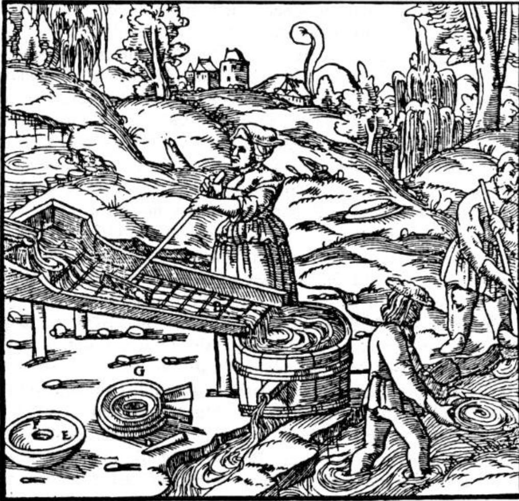
Separazione dell' oro tramite lavaggio (Agricola 1556)
