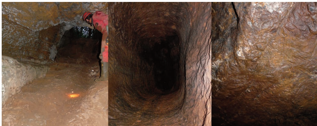
Fig. 31. Interno di alcune 'canope' nelle quali sono evidenti le tracce di scavo manuale (nella foto centrale un pozzo visto dal basso).
