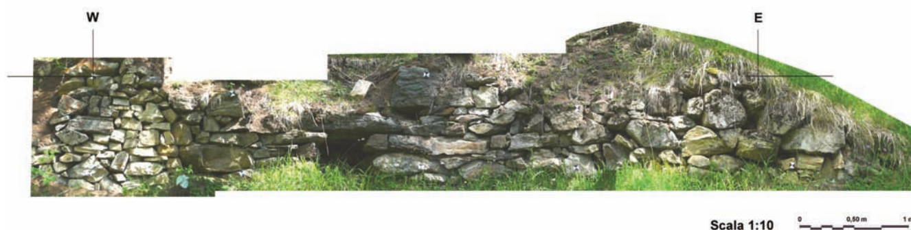
Fig. 17. Imbocco Tipo 3 - galleria con apertura sulla strada e struttura in muratura che sostiene tutto il versante [elaborazione grafica Morena Tramonti].
