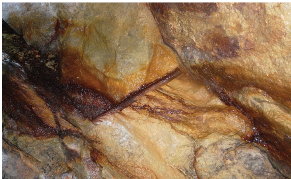
Fig. 3. Traccia di fioretto all'interno di una galleria mineraria presso Faedo (loc. Canopi, TN).
