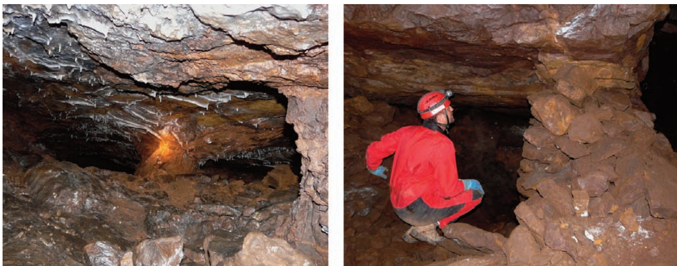
Fig. 32. Interno di alcune 'canope': nella foto di destra il muretto divisorio è stato realizzato con la roccia scartata dai minatori ("ripiena").
