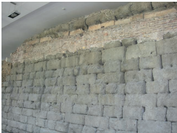
Fig. 18 - Il «Muro Romano», fronte Ovest, particolare degli interventi tardo-rinascimentali.
