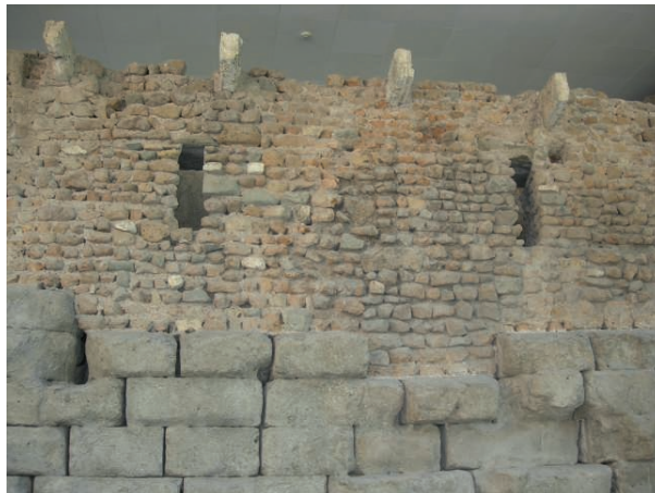
Fig. 17 - Il «Muro Romano», fronte Ovest, particolare degli interventi medievali.
