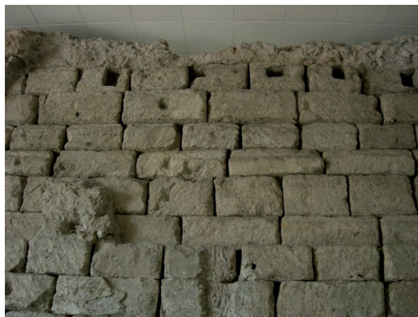
Fig. 20 - Il «Muro Romano», fronte Est, particolare della muratura.
