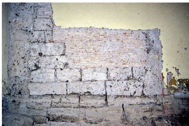
Fig. 19 - Museo Nuovo, Sala IV. Parte del setto murario E-O.
