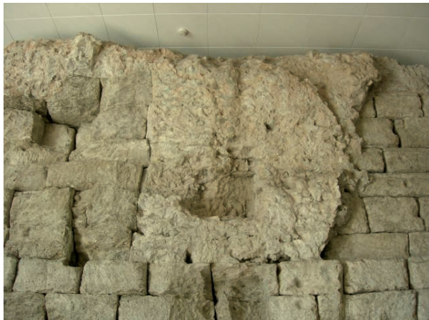
Fig. 16 - Il «Muro Romano», fronte Est, particolare degli interventi in conglomerato cementizio.
