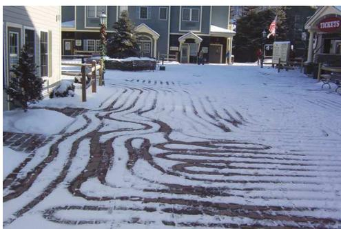
**Scioglimento delle nevi:** un totale di due milioni di metri quadrati di pavimentazione è riscaldata nel mondo (Argentina, Islanda, Giappone, Svizzera e USA) per un impiego di potenza di 311 MW.
