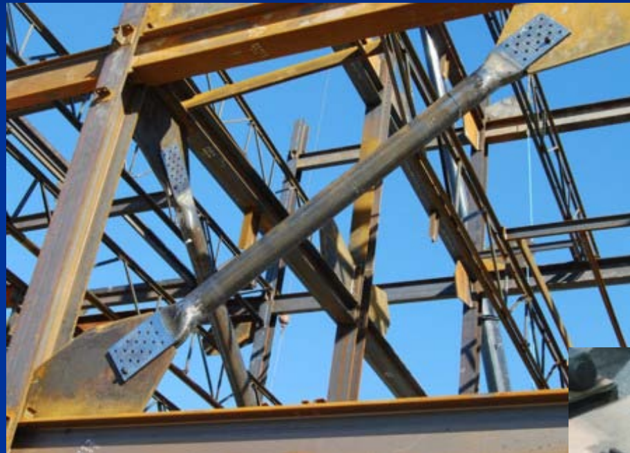
Campata controventata con profili scatolari rotondi (Caso 2)
