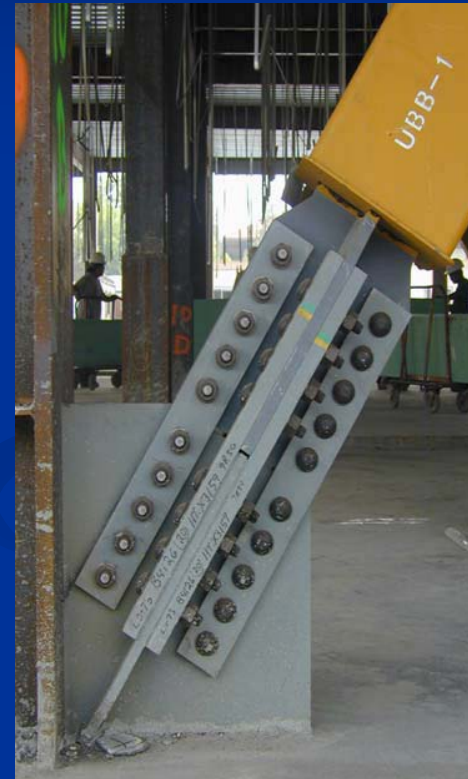
Struttura con controventi ad instabilità impedita con collegamenti non incernierati
