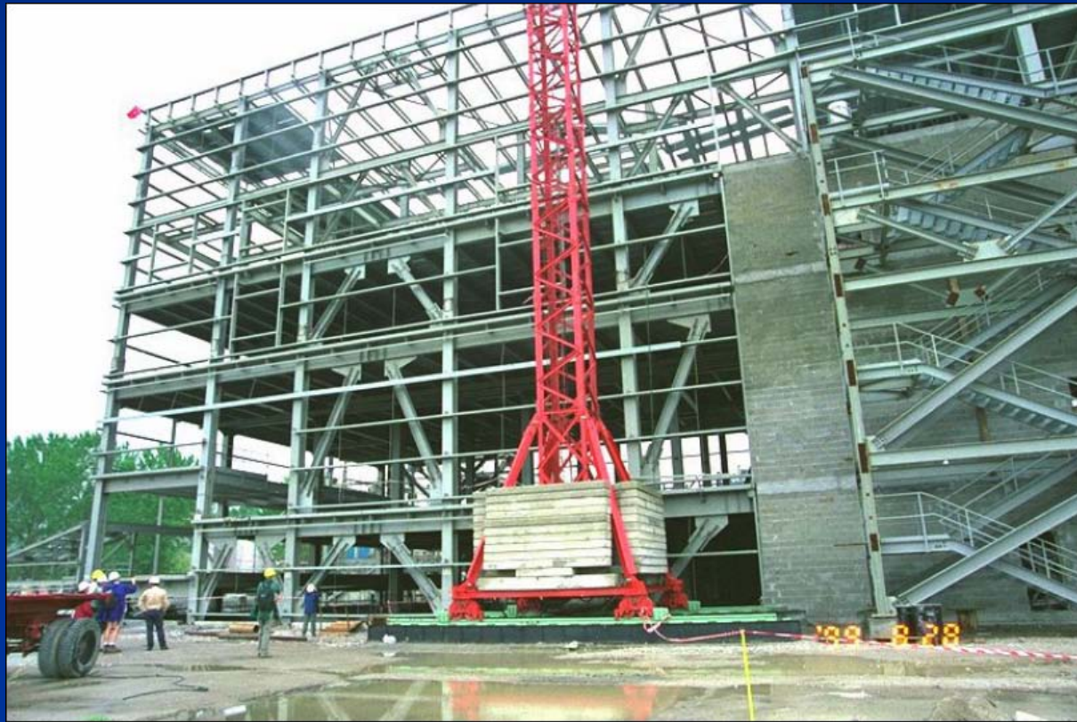
Edificio con controventi eccentrici
