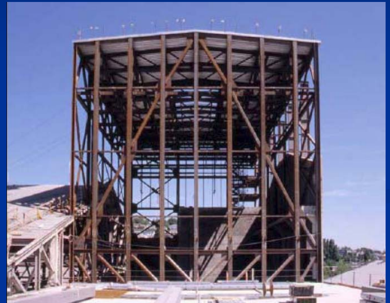
Strutture con controventi concentrici (Caso 2)
