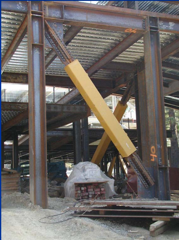
Struttura con controventi ad instabilità impedita con collegamenti non incernierati
