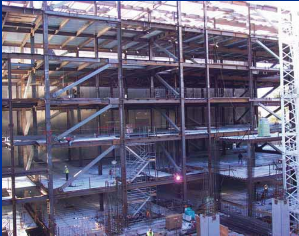
Strutture con controventi ad instabilità impedita
