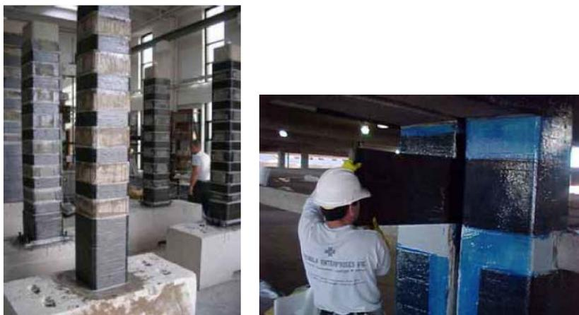
Figura 94 – Fasciatura di pilastro in FRP
