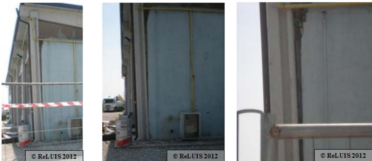
**Figura 48 – Perdita di verticalità del pilastro con fessurazione alla base**
