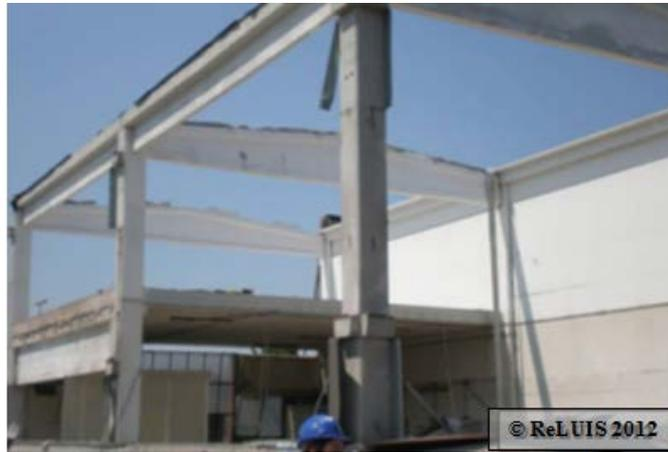
**Figura 13 - Collasso dei tegoli di copertura per perdita di appoggio in un edificio prefabbricato con travi principali trasversali**
