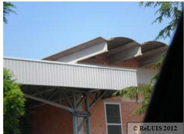
Figura 20 – Collasso della copertura con tegole ad Y
