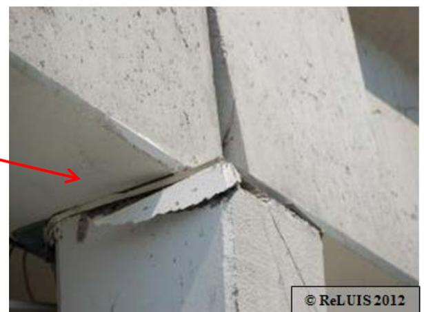
**Figura 17 – Inadeguatezza del vincolo trave-colonna con danneggiamenti locali del pilastro e rotazioni permanenti della trave in copertura**
