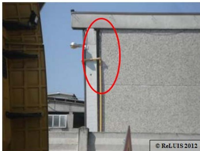
**Figura 50 – Perdita di verticalità del pilastro**
