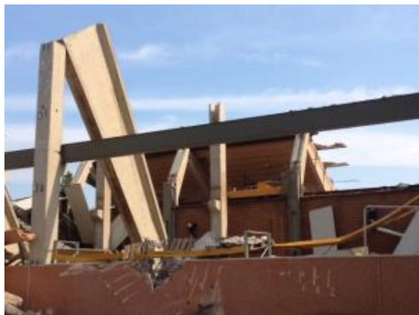
**Figura 5 – Perdita di appoggio della trave principale in un edificio monopiano prefabbricato con travi principali trasversali**
