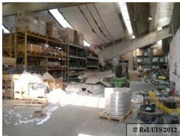
**Figura 4 – Colasso dei tegoli in un edificio monopiano prefabbricato con travi principali trasversali, probabilmente causato dal collasso della trave trasversale**
