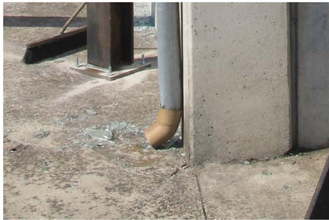
**Figura 53 – Rotazione alla base del pilastro**
