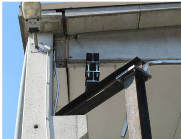
**Figura 10 - Perdita di appoggio della trave con inserimento di dispositivo di sostegno temporaneo**
