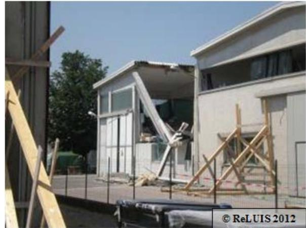
**Figura 3 – Perdita di appoggio della trave principale in un edificio monopiano prefabbricato con travi principali trasversali costruito recentemente in ampliamento di un edificio esistente con connessione trave-pilastro attrittiva**
