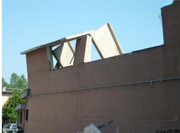
**Figura 6 - Perdita di appoggio della trave e collasso della copertura**
