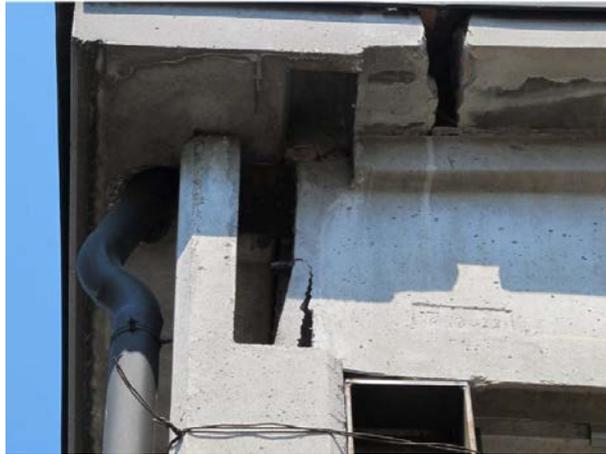
**Figura 9 - Perdita quasi completa dell'appoggio della trave**
