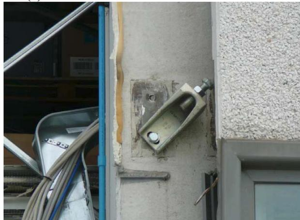
**Figura 36 - Rottura attacco mensola di supporto pannello e conseguente crollo del pannello**
