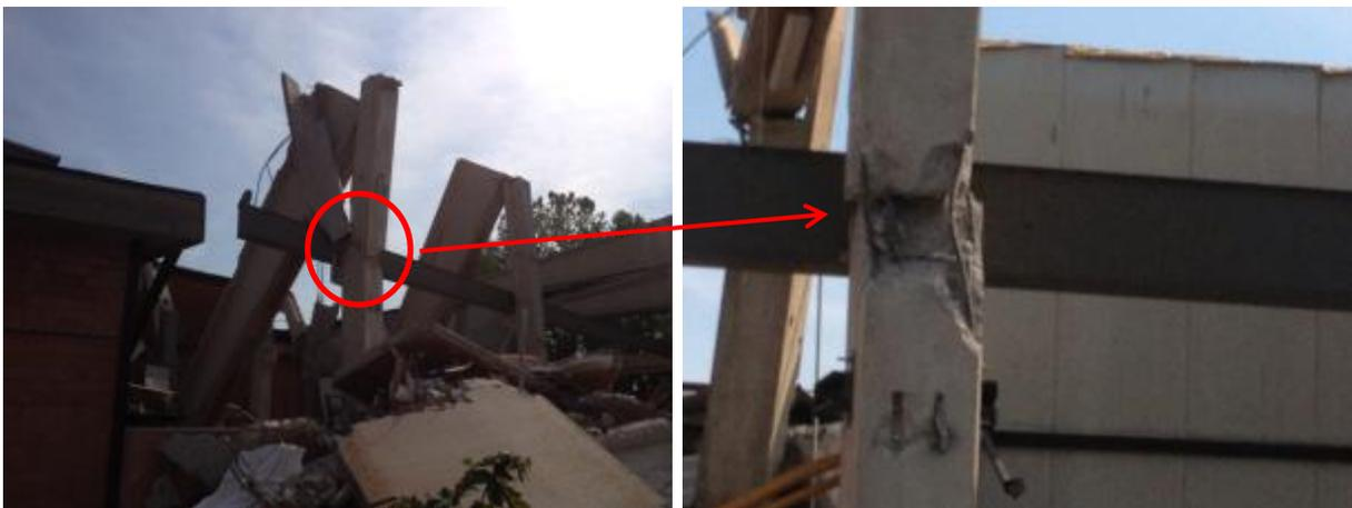
**Figura 59 – Formazione cerniera plastica in corrispondenza della mensola tozza, appoggio della trave porta-carroponte**
