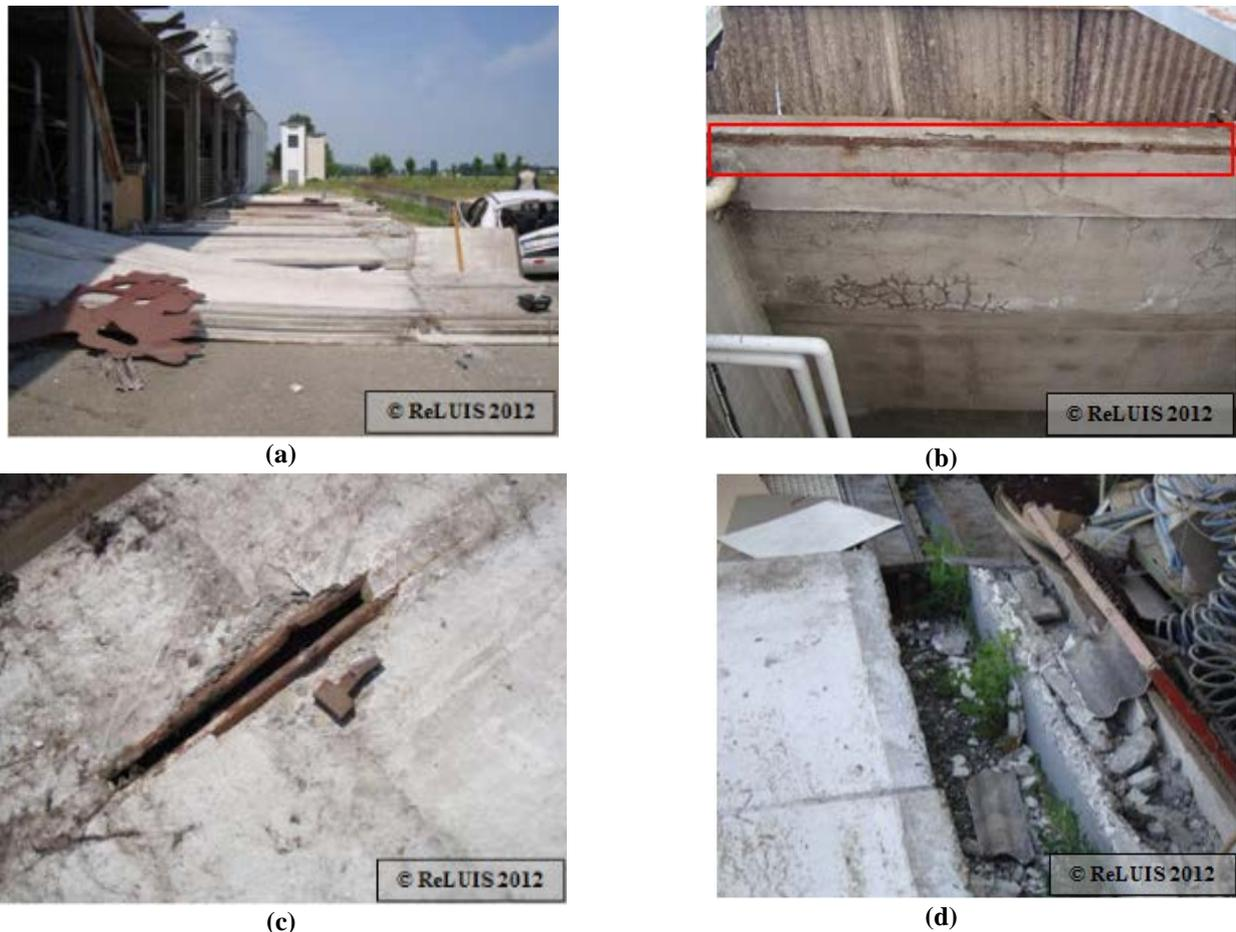
Figura 41 – (a) Crollo dei pannelli verticali di tamponamento: (b) dettagli profilo di acciaio saldato sotto la trave, (c) dettaglio connettore in acciaio saldato sulla piastra saldata alla trave ed inserito nel profilo incavo del pannello tramite la testa a martello e (d) trave reggipannello
