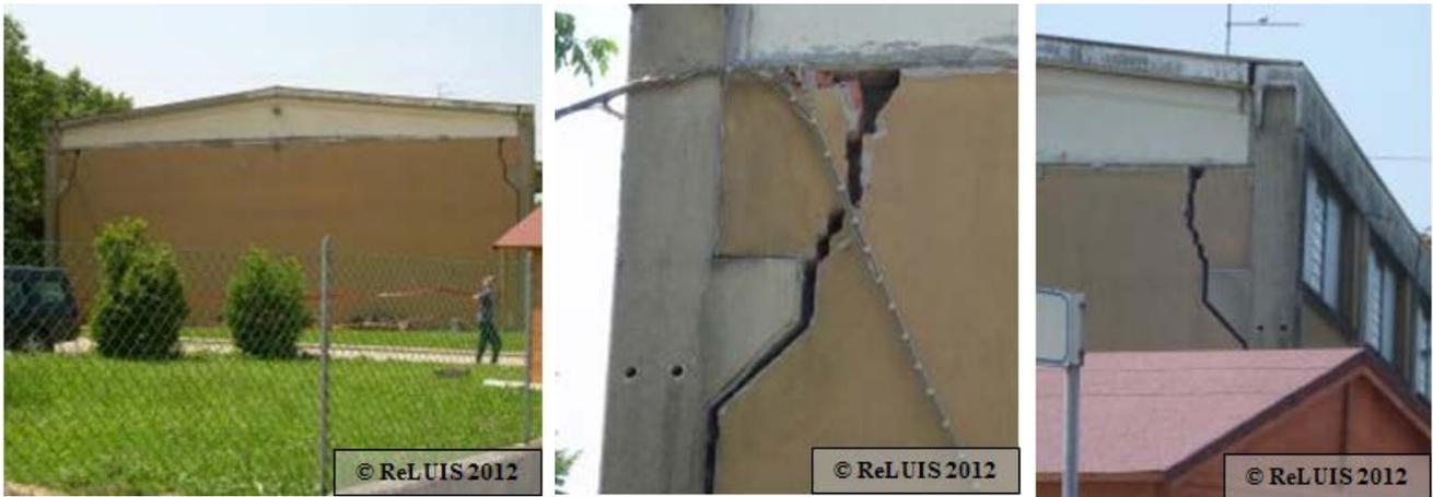
**Figura 46 – Perdita di verticalità dei pilastri in un edificio monopiano prefabbricato per possibile, ma non accertato, problema a livello della fondazione**
