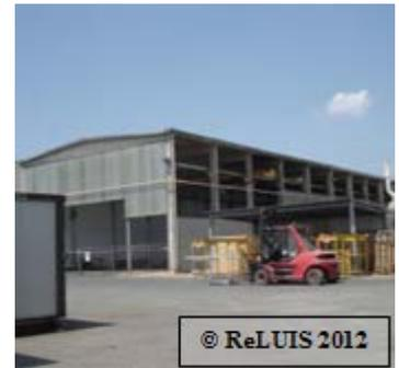
**Figura 26 – Collasso pannelli orizzontali di tamponamento in strutture monopiano prefabbricate**
