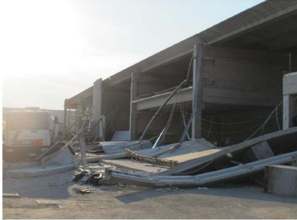
**Figura 42 –Collasso pannelli verticali di tamponatura di un edificio prefabbricato**
