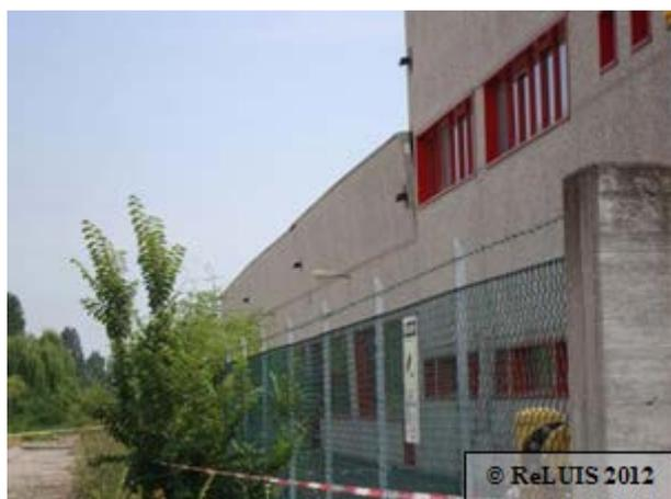
Figura 31 - Collasso incipiente dei pannelli orizzontali di tamponamento in un edificio monopiano prefabbricato
