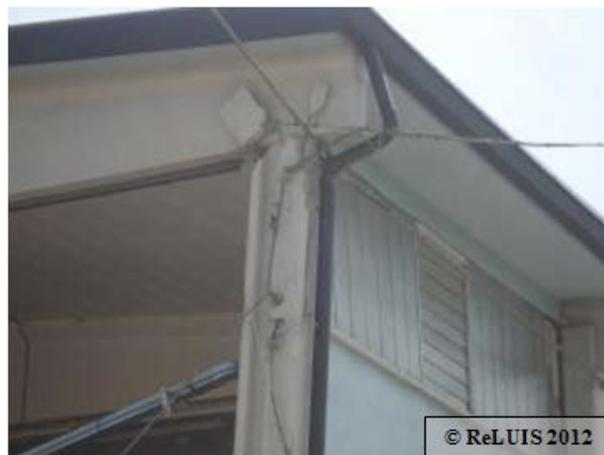
**Figura 18 – Crisi della forcella in testa ai pilastri per martellamento della trave in un edificio monopiano prefabbricato con travi principali trasversali**
