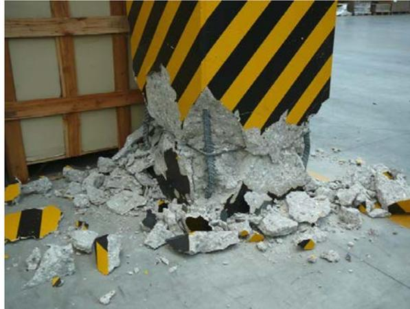
**Figura 58 - Cerniera plastica alla base del pilastro**
