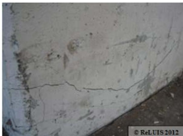
**Figura 55 - Fessurazione alla base dei pilastri di un edificio monopiano prefabbricato**
