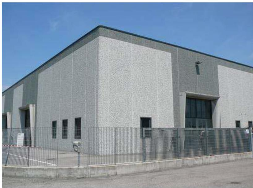
**Figura 73 - Esempio di tamponamento esterno ai pilastri con pannelli prefabbricati - pannelli verticali**
