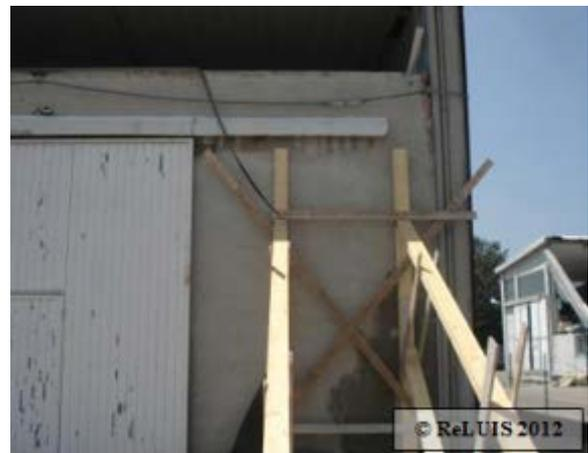
**Figura 44 - Collasso incipiente per meccanismo fuori dal piano dei pannelli in laterizio in una struttura prefabbricata monopiano di non recente costruzione**
