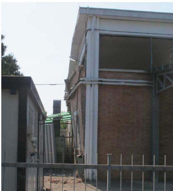
**Figura 45 –Crisi per meccanismo fuori dal piano di un pannello di tamponatura in laterizio in un edificio monopiano prefabbricato**
