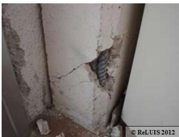
**Figura 57 - Espulsione del copriferro alla base del pilastro con carenza di armature trasversali**
