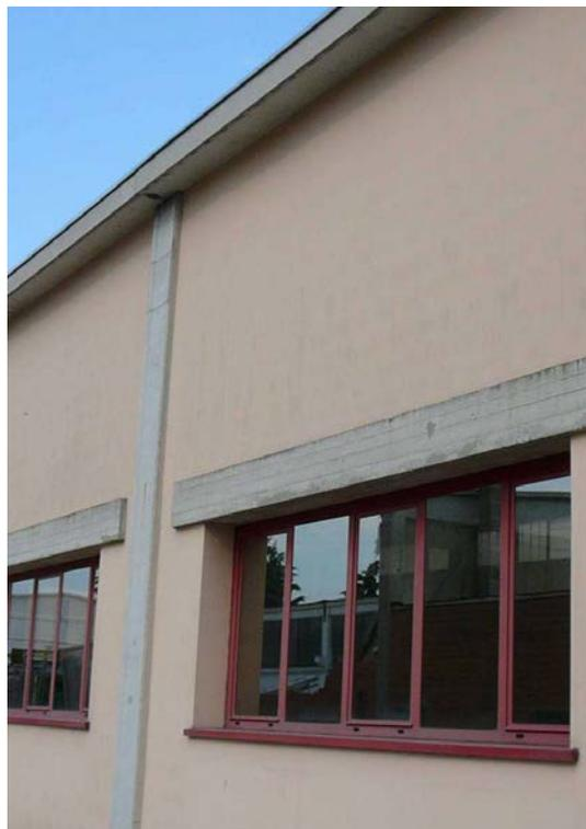
**Figura 72 - Esempio di tamponamento in luce di pilastro con muratura in laterizio**
