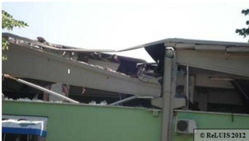
Figura 1 - Perdita di appoggio della trave in un edificio monopiano prefabbricato con travi principali trasversali di non recente costruzione
