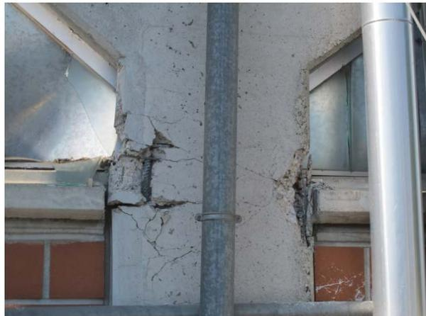
**Figura 60 - Danneggiamento del pilastro tozzo causa interazione con la tamponatura**
