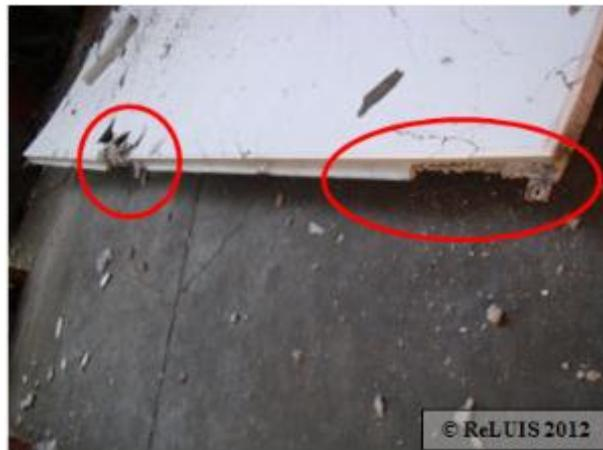
Figura 19 – Collasso di una lastrina di copertura in un edificio monopiano prefabbricato con trave principale longitudinale
