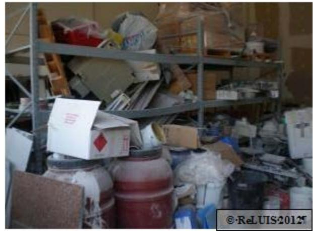
**Figura 61 – Danneggiamento scaffalatura con conseguente perdita del materiale contenuto**
