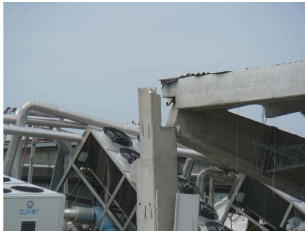
**Figura 16 - Collasso capriata per perdita di appoggio**
