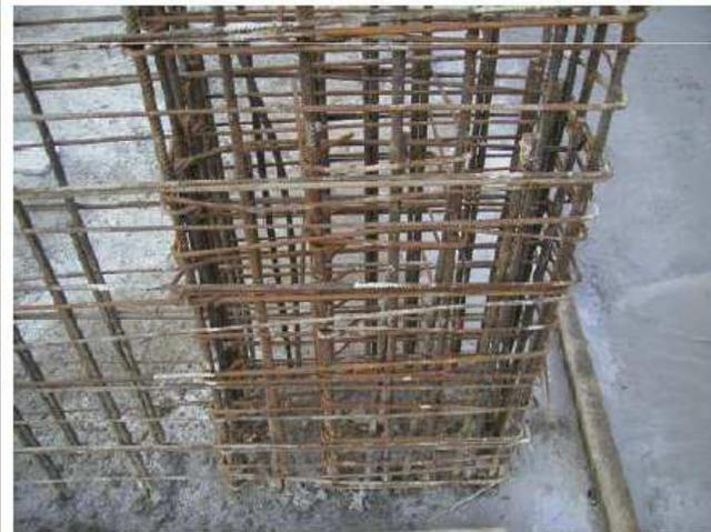
**Dettagli armatura nello spigolo**
