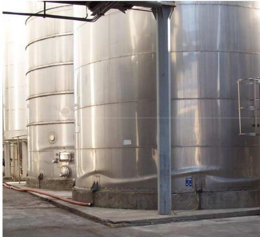
**collasso a “zampa di elefante” di serbatoi di stoccaggio in una cantina per effetto dell’evento sismico di Correggio del 1996.**
