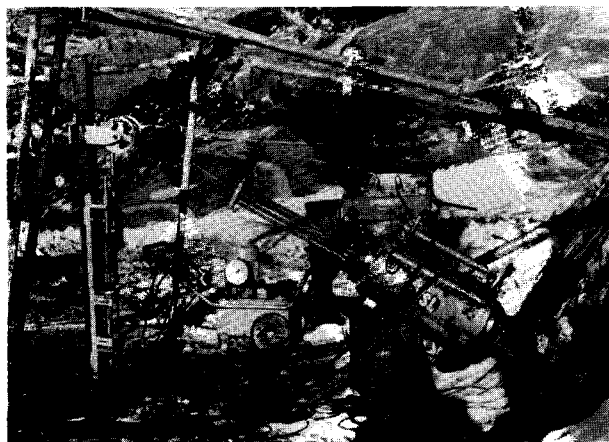
Fig. 6. — Réalisation d'un essai préalable sur tirant TMD scellé dans les éboulis de pente.
