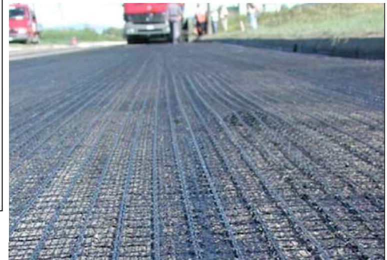
Figura 3.11: Possibili applicazioni di geosintetici nelle strade pavimentate.
