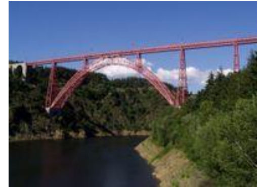
Il ponte ferroviario Garabit (Eiffel)
