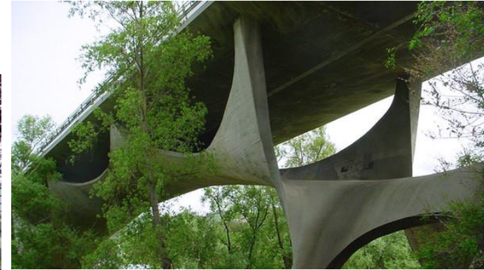
S. Musumeci, Ponte sul Basento, (1972)
