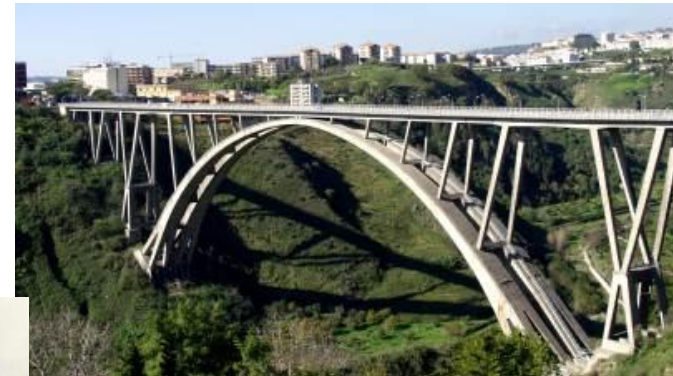
R. Morandi, Ponte Bisantis, Catanzaro, (1962)
