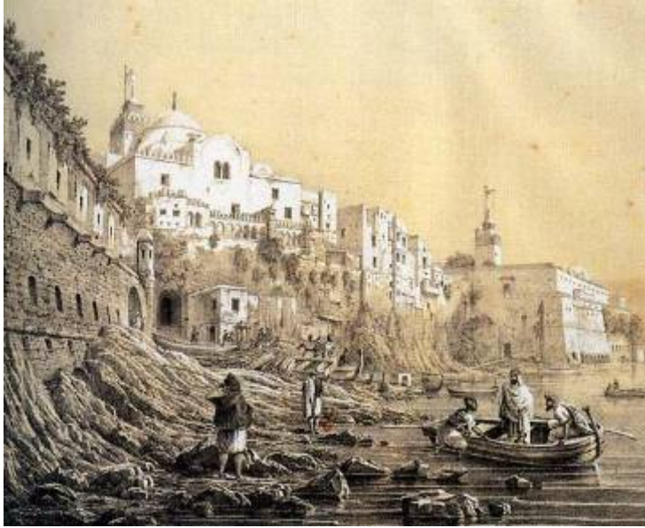
Vista fronte mare 1832
