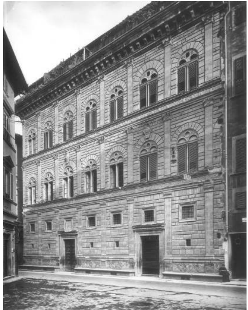
Firenze, palazzo Rucellai
