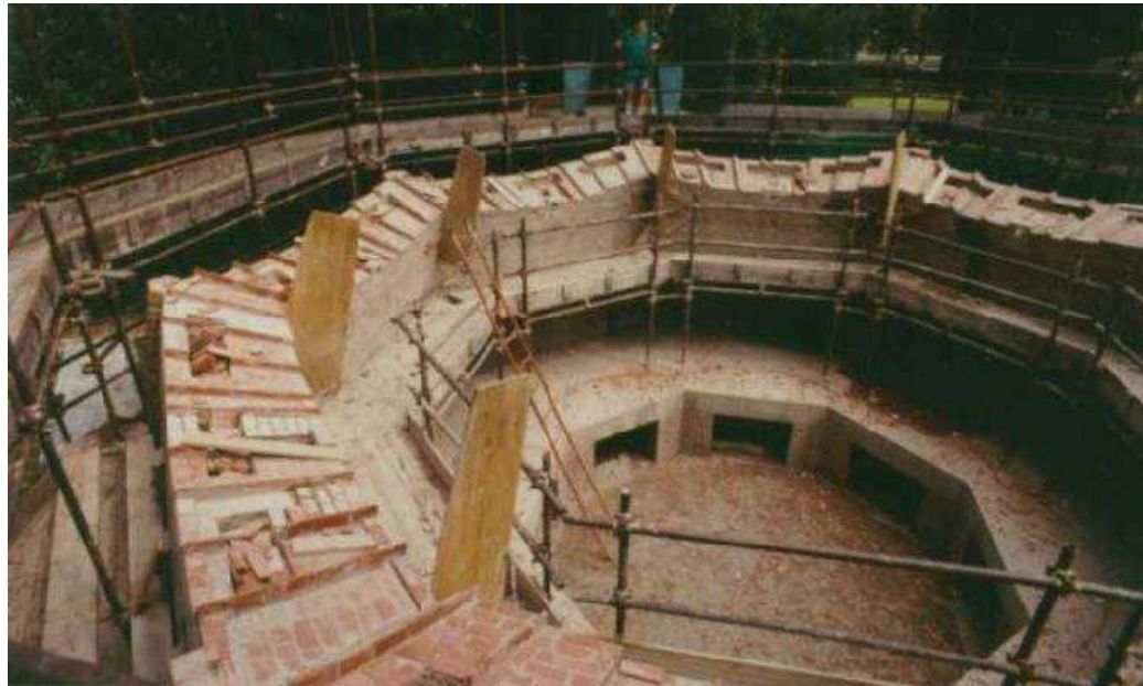
Modello in scala 1:5 della cupola di Brunelleschi in fase di costruzione
