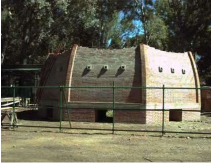
Modello in scala 1:5 della cupola di Brunelleschi in fase di costruzione
