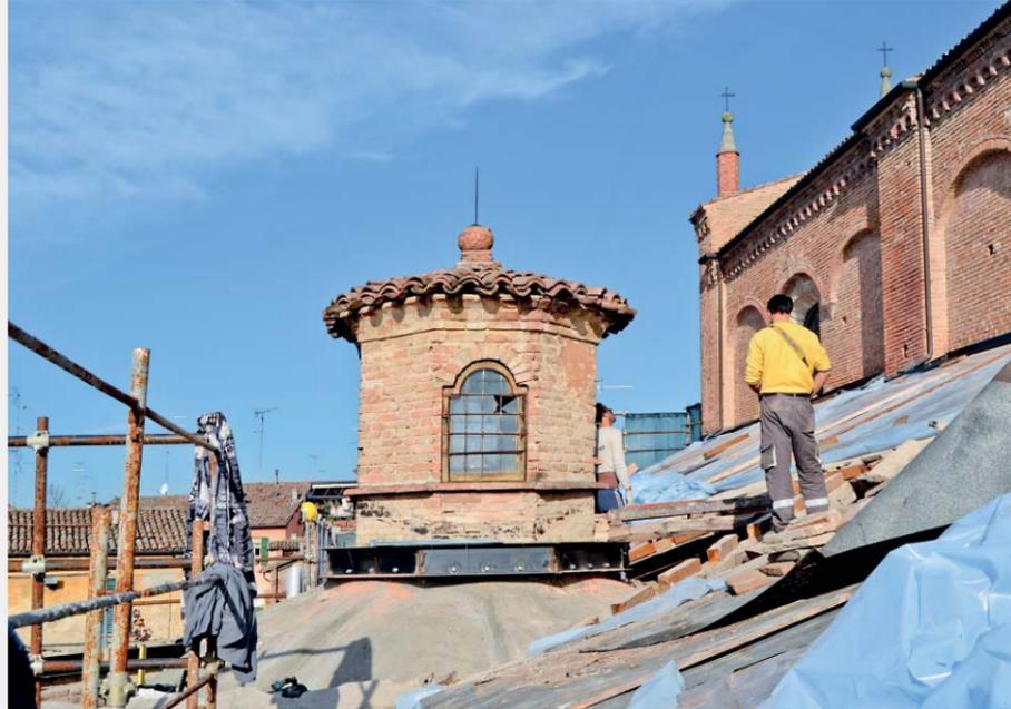
Chiesa di San Francesco (Correggio, RE), interventi di miglioramento sismico della copertura e delle lanterne laterali con travi in acciaio di scarico, a sinistra, e plattini di acciaio per la cerchiatura perimetrale.
