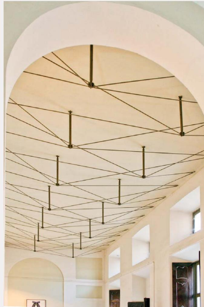
Olevano (PV), consolidamento di solaio esistente mediante tensostruttura metallica. A destra. Castelvecchio (Verona), esempio di sistema di lettura tattile di un dipinto su tavola. Olevano (Pavia). Reinforcing an existing ceiling using a metal tensile structure. Right. Castelvecchio (Verona). Example of a tactile reading system for a panel painting.
