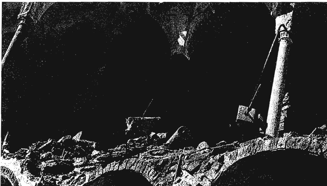
Fig. 6 - Milano, Ospedale Maggiore, i danni prodotti dai bombardamenti alle strutture del chiostro grande (dettaglio).
