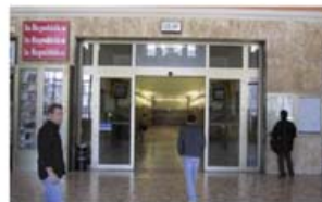
IL FABBRICATO VIAGGIATORI IN RISTRUTTURAZIONE
