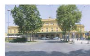
IL FABBRICATO VIAGGIATORI IN RISTRUTTURAZIONE
