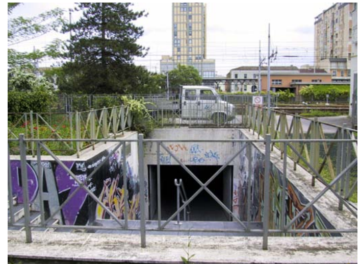
Attraversamento pedonale - Ravenna
