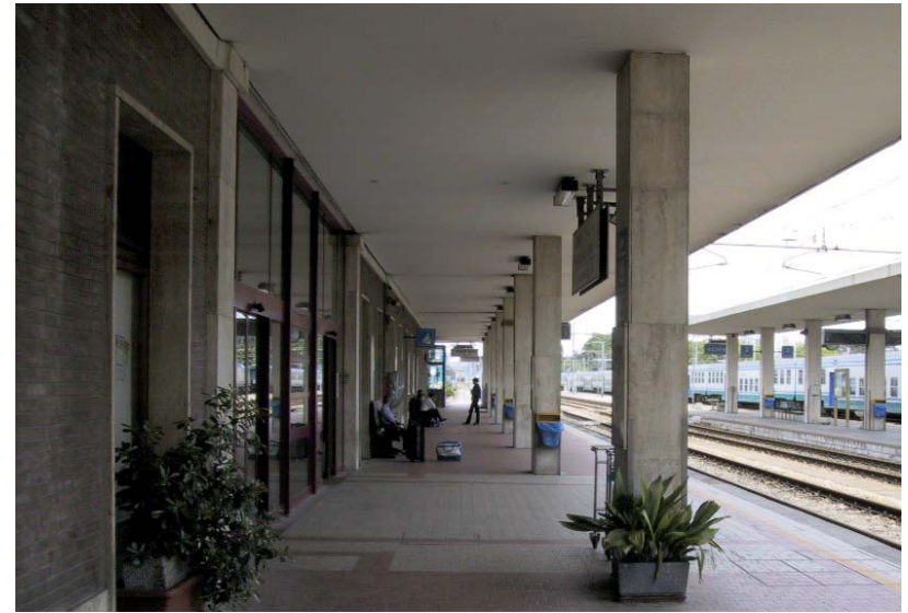
Sistemazioni e arredi banchine - Medie stazioni
