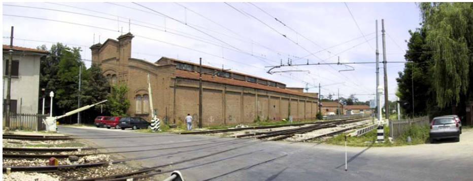
Attraversamento a raso - Lugo
