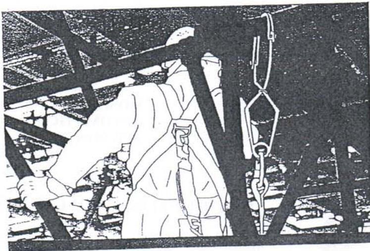
I connettori a doppia sicurezza di tipo automatico o per ponteggi, sono facili da maneggiare anche con una sola mano. La chiusura e il bloccaggio automatico li rendono adatti all'uso frequente.
