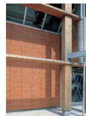
Nell'edificio dell'arch. Alessandro Scarpa alla parete ventilata in cotto fanno da contrappunto i pilastri in legno lamellare e gli elementi in lamiera zincata.
