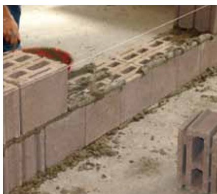
Allineamento con filo orizzontale
