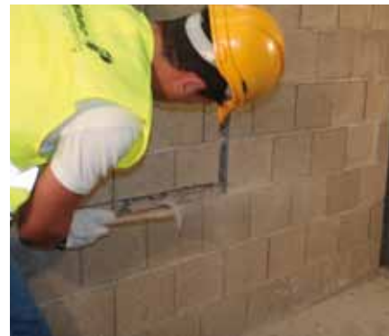
Finitura tracce con mazzetta
