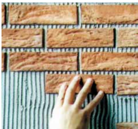
CORTINA LISTELLO Tipo WF: 210 x 50 mm Tipo NF: 240 x 70 mm
