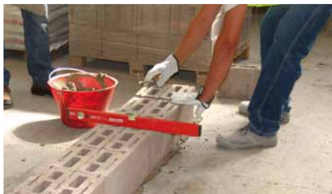
Posa primo corso e controlli allineamento e bolla
