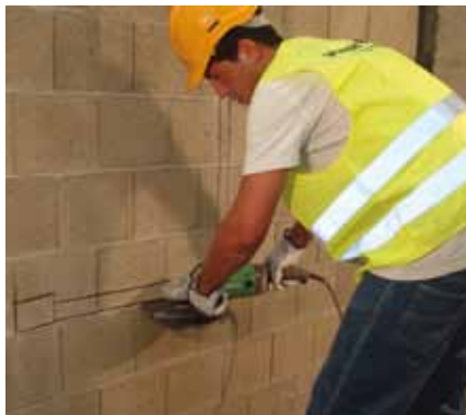
Tracce per inserimento impianti
