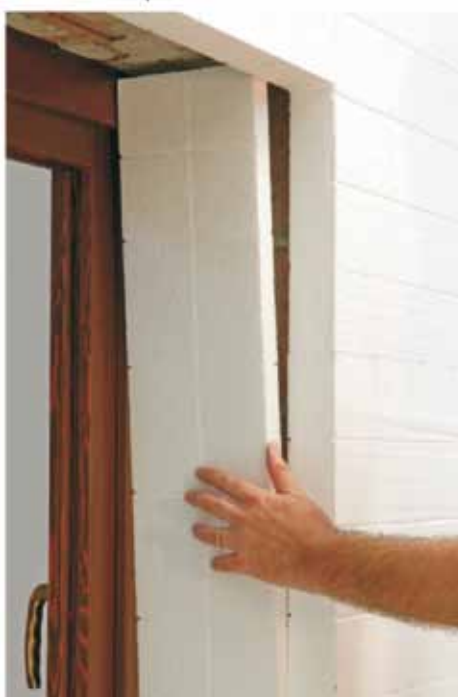
Esecuzione spallette finestra
