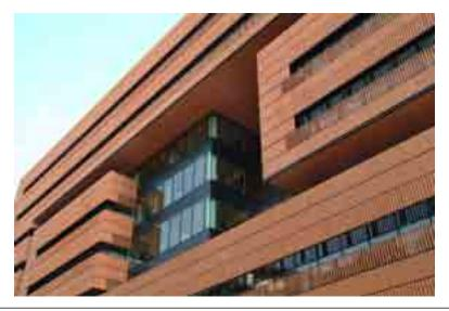
5. Installazione esterna fissa: dispositivi frangisole verticali "passivi".
