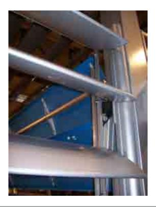
15. Installazione esterna mobile: dispositivi frangisole orientabili a pale. L'applicazione dei dispositivi lamellari metallici rileva la messa a punto dei componenti realizzati dalle pale ellissoidali in alluminio estruso anodizzato, in lamiera preverniciata e pressopiegata. (produzione Merlo)
