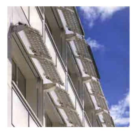
32. Combinazione con moduli fotovoltaici. I dispositivi di calibrazione luminosa sono dotati di celle fotovoltaiche cristalline in silicio, che convertono la radiazione solare in energia elettrica, garantendo la schermatura alla luce naturale. (produzione Schweizer)
