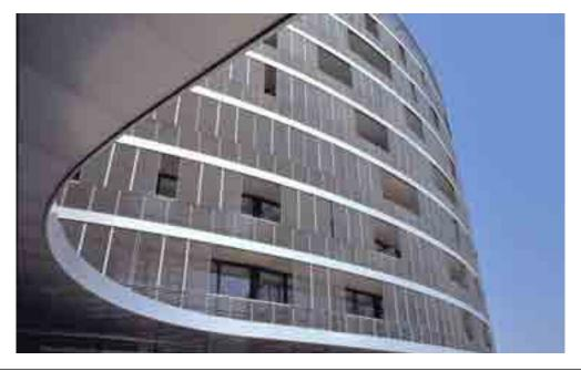
20. Installazione esterna mobile: persiane scorrevoli. Le schermature composte dalla trama dei dispositivi frangisole scorrevoli osservano la costituzione in lamelle orizzontali (ad esempio, di profilati estrusi in alluminio), in parte fisse e in parte mobili su monorotaia. (Norman Foster and Partners, World Trade Center, Dogana, Repubblica di San Marino)
