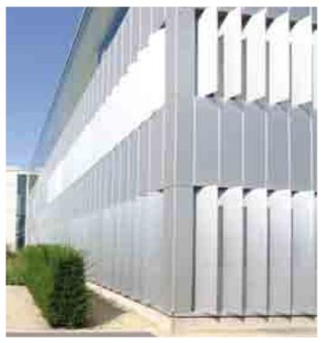
4. Installazione esterna fissa: dispositivi frangisole verticali "passivi". Il funzionamento delle schermature comporta la riduzione della radiazione solare per riflessione, attraverso l'ausilio o l'assenza dell'intelaiatura di supporto agli elementi schermanti, realizzati alla distanza finalizzata a intercettare i raggi incidenti rispetto all'angolo solare. (sistema Shadometal, produzione Colt International)
