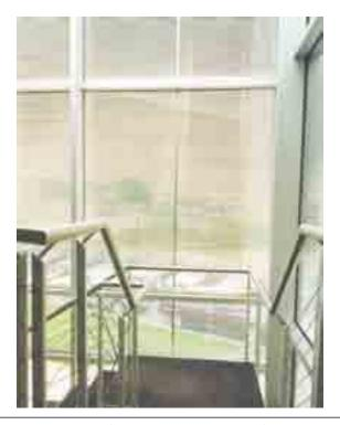
26. Installazione integrata (intercapedine vetrocamera): schermi in reticolo. Le schermature in forma di griglia plastica incorporano un rivestimento in alluminio sulla superficie esterna per riflettere la radiazione incidente e una texture per ridurre la re-irradiazione, con il conseguente abbagliamento, negli spazi interni. (produzione Okalux Kapillarglas)
