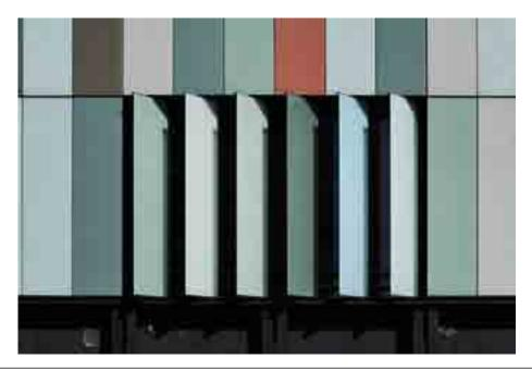
13. Installazione esterna mobile: dispositivi orientabili azimutali. La formulazione dei frangisole orientabili, realizzati in vetro trattato tramite la serigrafia opaca colorata (che consente un elevato livello di trasparenza, anche in posizione chiusa), sono orientabili per mezzo del perno di rotazione verticale. (Matthias Sauerbruch e Louisa Hutton, settore "Mac567", Maciachini Center, Milano)
