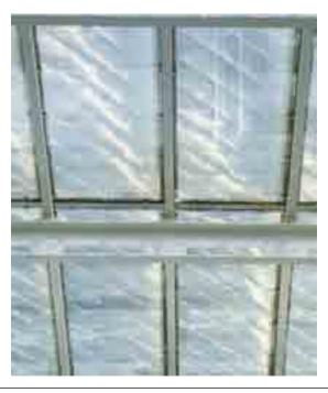
27. Installazione integrata (intercapedine vetrocamera): schermi a micro lamelle. Le schermature lamellari preorientate, incorporate nell'intercapedine delle lastre in vetrocamera (con vetri di tipo laminato o stratificato), attenuano sia la radiazione solare diretta, sia i fenomeni di contrasto visivo e di abbagliamento.
