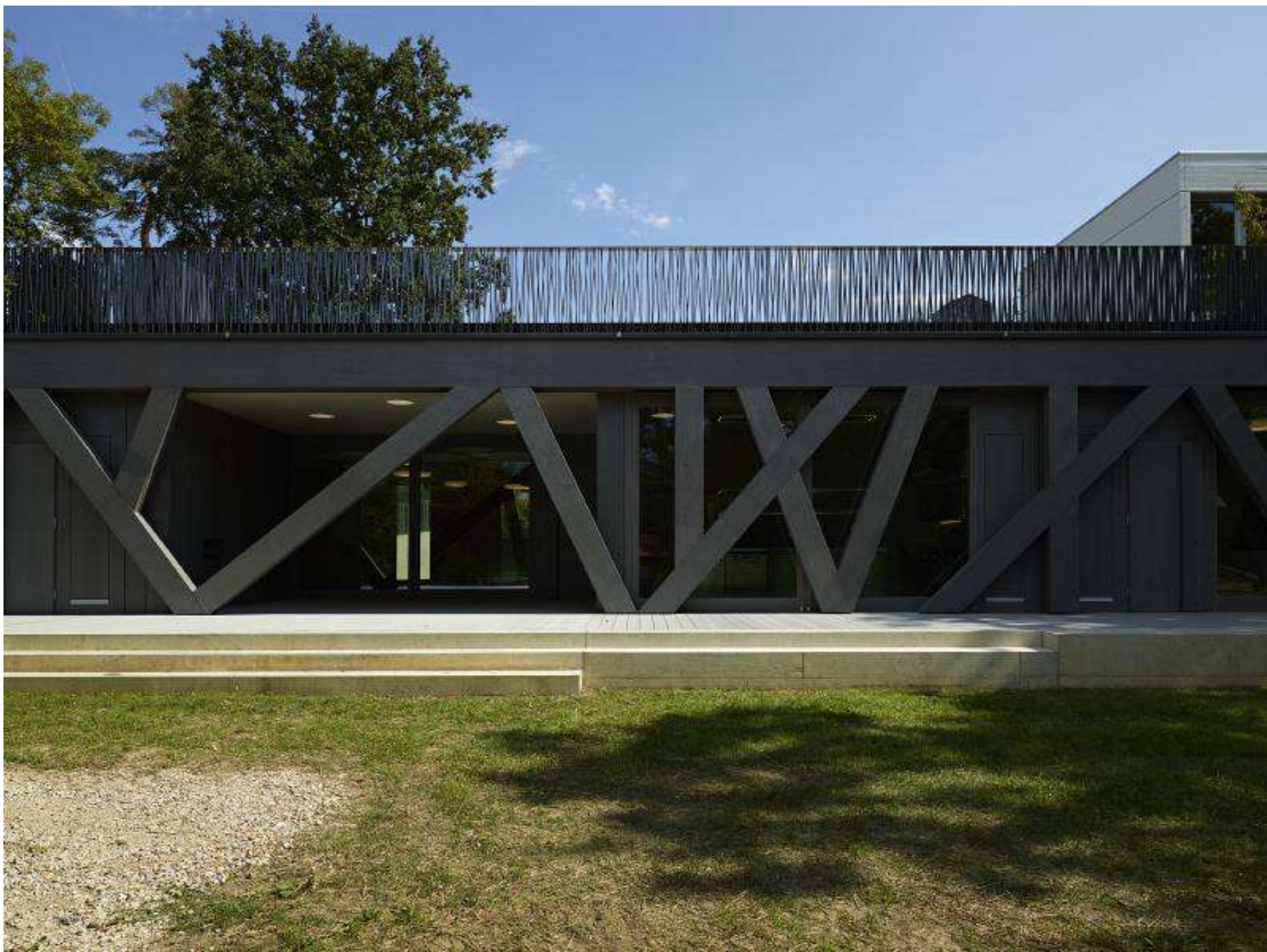
STENDARDO MENNINGEN ARCHITECTES, JARDIN ROBINSON DU LIGNON
