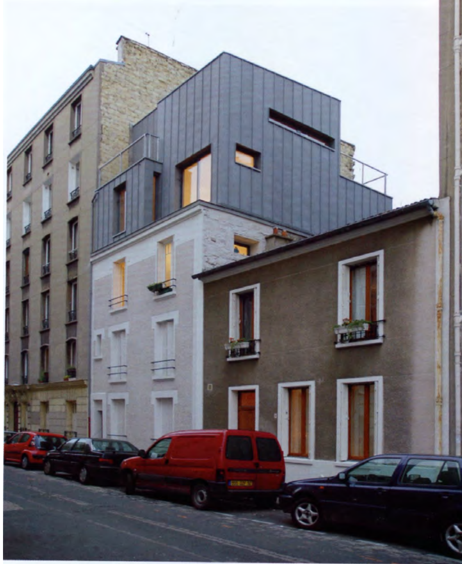
Sopraelevazione a Parigi. La sopraelevazione ha "pagato" la ristrutturazione totale della palazzina
