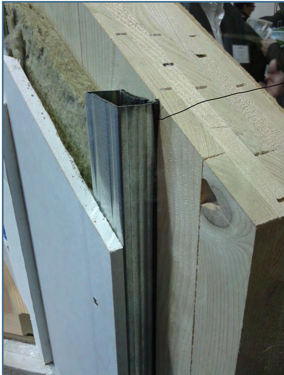
striscia di materiale isolante per limitare il ponte termico del montante metallico e, in parte, per limitare il trasferimento del rumore attraverso il montante
