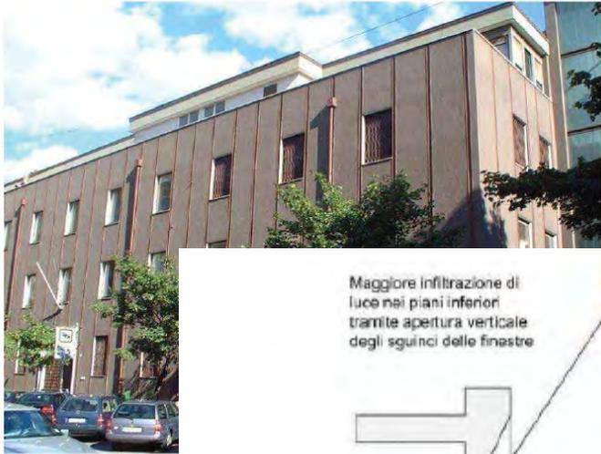
Maggiore infiltrazione di luce nei piani inferiori tramite apertura verticale degli sguinci delle finestre
