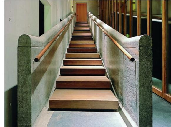
Fig. 39 - Protezione della rampa di scala e profili di corrimani.
