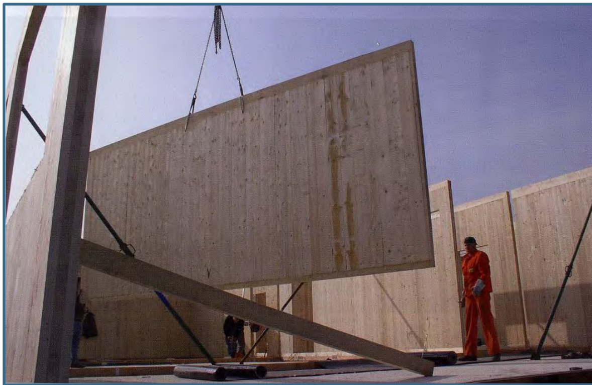
Sistema di sollevamento e posizionamento pareti interne
