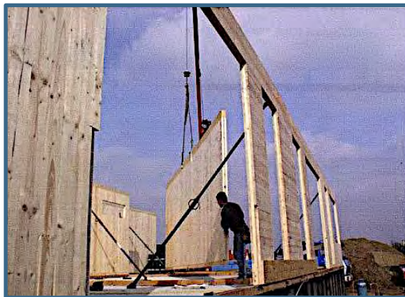
Fase di montaggio pareti interne
