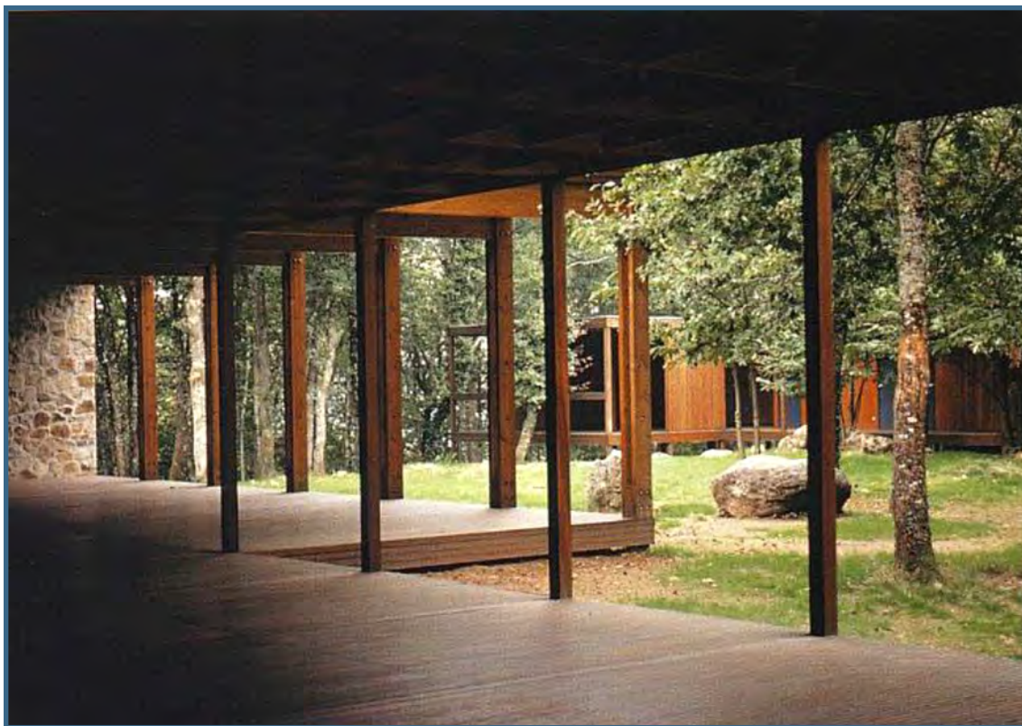
Vista sud-est verso la parte centrale
