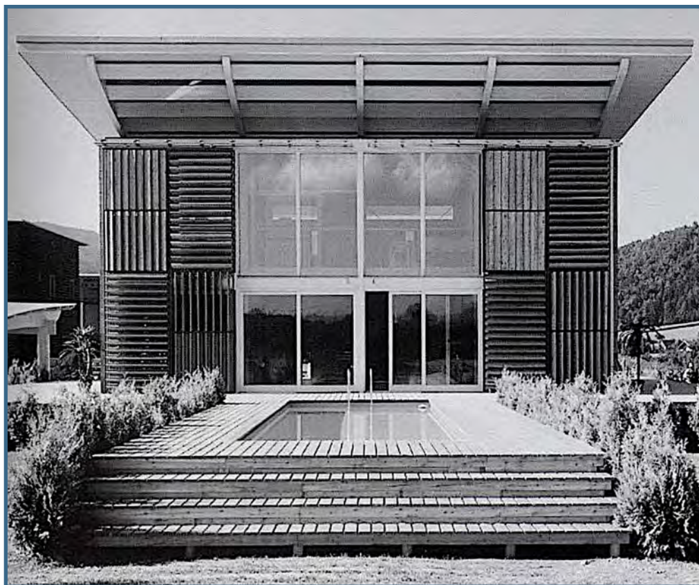
Vista diurna facciata sud
