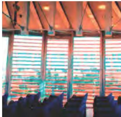
Nel caso di frangisole a lamelle fissi è molto importante progettare correttamente la sezione e la distanza tra gli elementi.
