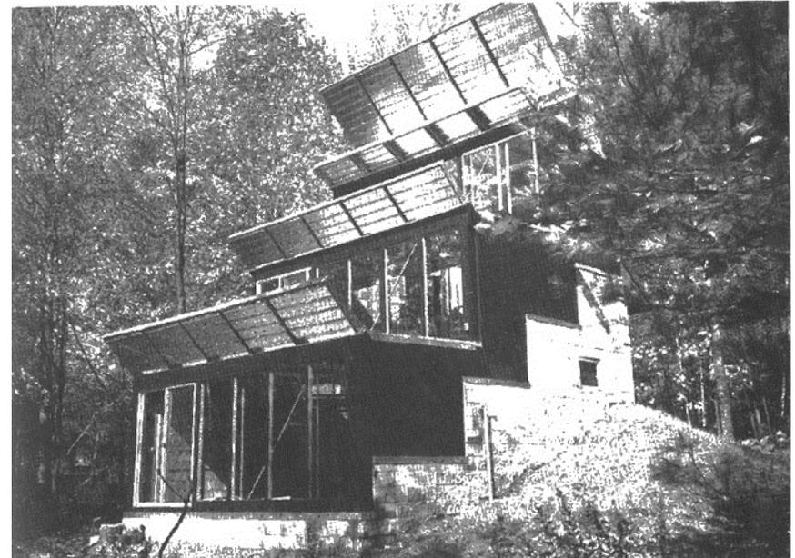
Necessita di una progettazione "ad hoc" attraverso diagrammi solari e maschere di ombreggiamento
