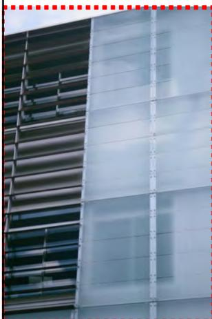
Il sistema di connessione tra i pannelli vetrati è realizzato mediante piatti in acciaio che lasciano la lastra completamente esterna. Il giunto di tenuta è a silicone.
