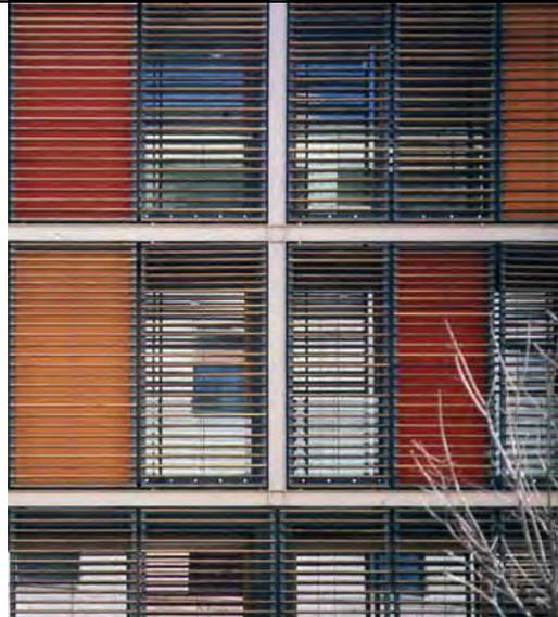
Nel caso di frangisole a lamelle fissi è molto importante progettare correttamente la sezione e la distanza tra gli elementi.
