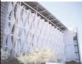
LE LAMELLE O ELEMENTI TESSILI SONO GENERALMENTE SOSTENUTE DA UNA STRUTTURA METALLICA IN PROFILI DI ALLUMINIO O DI ACCIAIO. LA SEZIONE DELLE LAMELLE PUO' ESSERE LINEARE, ELISSOIDALE O CIRCOLARE, REALIZZATA CON NERVATURE CENTRALI PER TUTTA LA LUNGHEZZA DELL'ELEMENTO PER DARE RIGIDEZZA ALLA STRUTTURA
