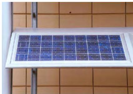
Facciata fotovoltaica distante circa **80 cm** dalla struttura dell'edificio ma collegata a questa tramite **profili metallici tubolari**
