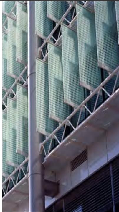
La facciata è tramata con colonne in cemento armato che sostiene un sistema di doppio rivestimento che funziona come un diaframma.
