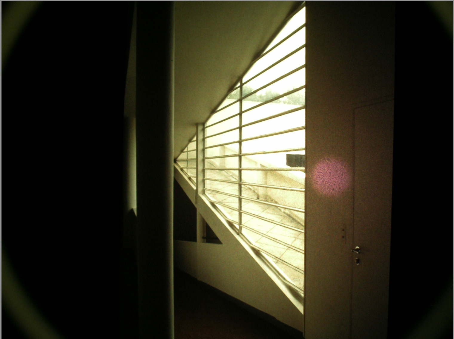
Ville Savoye: interno con vista sulla rampa
