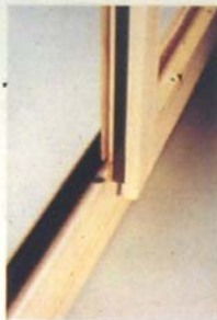
BOCCOLE tronco-coniche in nylon per i chiodi terminali delle chiusure.
