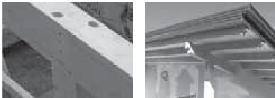
Figura 3.59_Diverse tipologie di collegamento fra trave e pilastro. A sinistra con giunto a mezzo legno tra le travi e collegamento con viti. A destra con sella d'appoggio sul pilastro e collegamento con viti.
