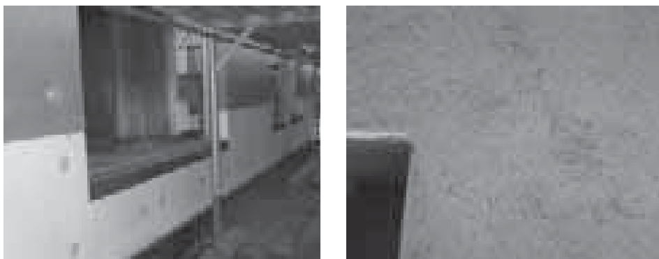
Figura 3.16_L'edificio, realizzato con struttura in XLam, è rivestito con pannelli di fibra di legno aderenti alla struttura protetti nella parte bassa da una fascia in polistirene; il successivo strato di intonaco rende la superficie non infiammabile e impedisce la propagazione del fuoco in facciata
