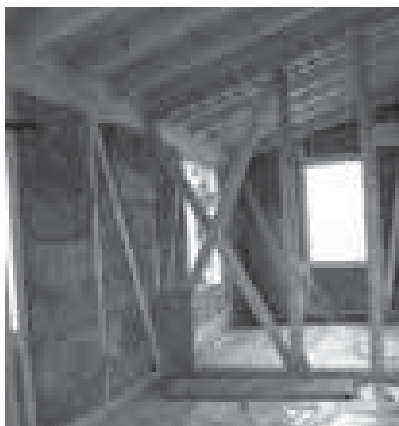
Figura 3.57 Edificio a travi e pilastri e controventi in legno massiccio con pareti esterne coibentate in balle di paglia.
