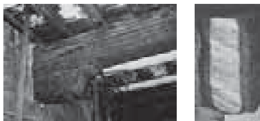
Figura 3.14_A sinistra: Solaio di legno non crollato a seguito di un incendio.
