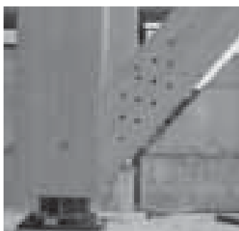
Figura 3.60_Collegamento corretto realizzato con un porta-pilastro in acciaio in modo da evitare possibili ristagni d'acqua e staccando il pilastro rispetto al piano delle fondazioni.
