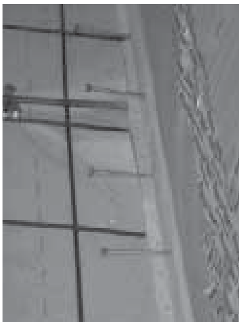
Figura 3.21_Realizzazione di un solaio misto legno-clt in un edificio XLam. Notare le viti di collegamento della parete al solaio che fuoriescono dalla base della parete prima del getto.
