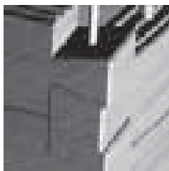
Figura 3.56_Giunto d'angolo fra pareti ortogonali tagliato a filo esterno parete e solidarizzato mediante l'inserimento di una barra d'acciaio passante.
