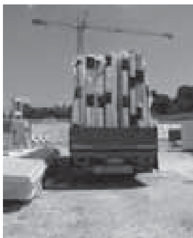
Figura 6.4_Pannelli a strati incrociati disposti secondo l'ordine di scarico.
