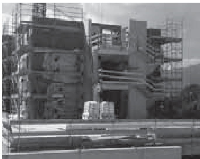
Figura 6.13_Parapetti installati sulle scale a protezione della caduta dall'alto.
