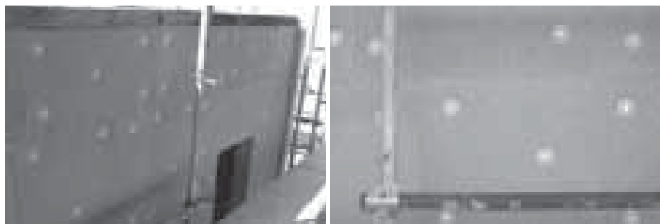
Figura 6.18_Posa del cappotto esterno in fibra di legno su un edificio in legno fissato con apposite viti autoforanti dotate di rondella e tappo di protezione anti-ponte termico.
