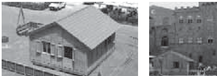
Figura 6.22_Prototipo della CLEA (Casette in Legno per le Emergenze Abitative) montata nel Giugno del 2000 in Piazza della Signoria a Firenze su Progetto della Regione Toscana e CNR-IRL. Il prototipo è stato poi successivamente smontato e rimontato presso la sede della Protezione Civile del Comune di Firenze, dove è situato attualmente. La CLEA è l'unico esempio realmente applicato finora in Italia di edificio smontabile.
