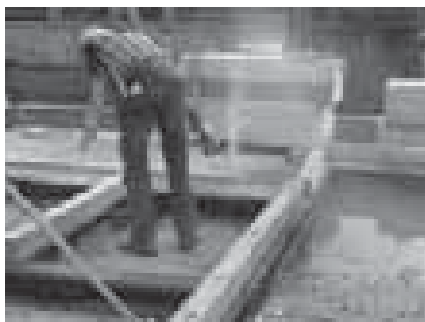
Figura 6.20_Utilizzo di aria compressa per pulire il foro dai residui, prima dell'ancoraggio del cordolo di base.
