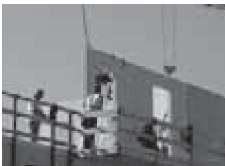
Figura 6.11_Posa in opera dei pannelli parete in un edificio senza l'utilizzo di ponteggi esterni. Tutti gli operatori sono assicurati contro il rischio di caduta dall'utilizzo di cordini di sicurezza.
