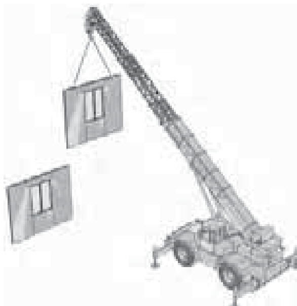
Figura 6.25_Posa di elementi parete preassemblati con gru meccanica.
