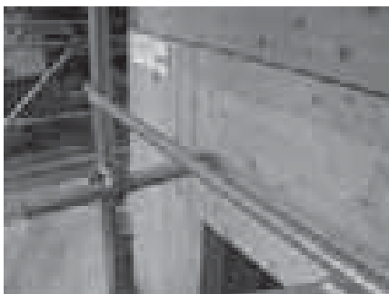
Figura 6.15_Particolare dell'ancoraggio del ponteggio alla struttura a pannelli a strati incrociati dell'edificio.
