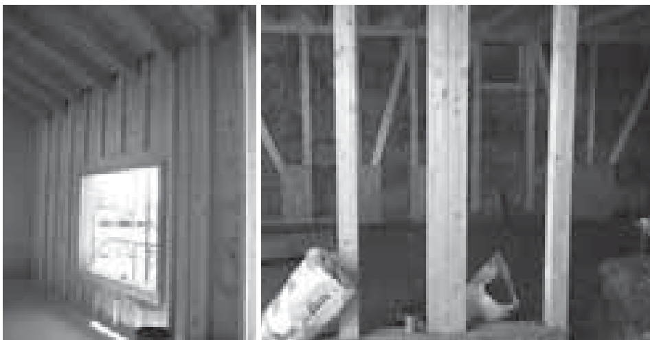
Figura 5.4_Parete di un edificio Xlam.
