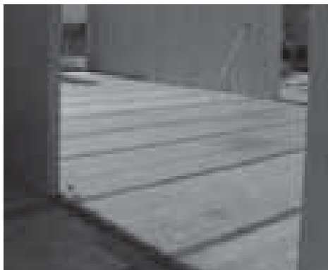
Figura 5.50_Collegamenti orizzontali fra pannelli solaio con strisce multistrato.
