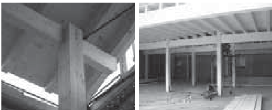
Figura 5.49_Diverse modalità di collegamento fra trave e pilastro: con sella di appoggio sul pilastro e collegamento con viti (a sinistra) e con pilastro composto da doppio elemento collegato alla trave passante e collegamento con viti (a destra).
