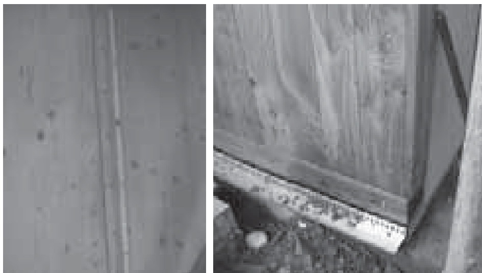
Figura 5.47_Giunto verticale fra pannelli parete realizzato con chiodi.
