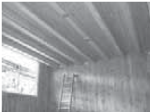
Figura 5.52_Solaio di copertura con pannelli travi di legno lamellare e irrigidimento con pannelli XLam.
