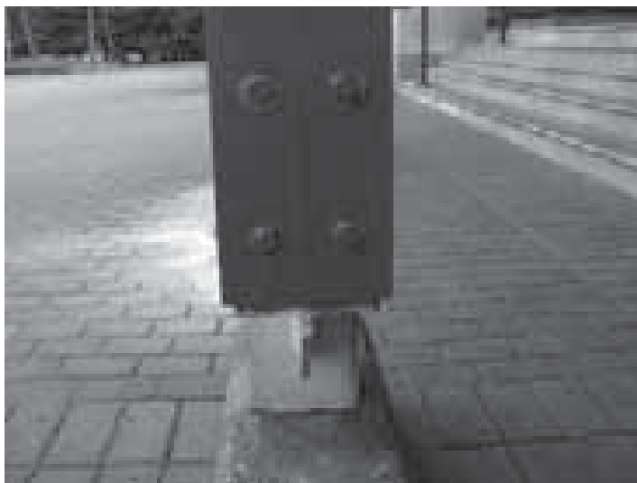
Figura 5.46_ Collegamento del pilastro alle fondazioni con porta pilastri in modo da distaccare il legno di 15 cm rispetto al livello finito del marciapiede.
