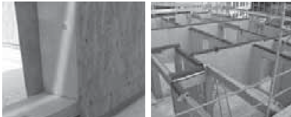
Figura 5.48 Collegamento fra pannelli di OSB e corrente inferiore della parete. A destra: Collegamento verticale fra pareti ortogonali in un edificio Platform.
