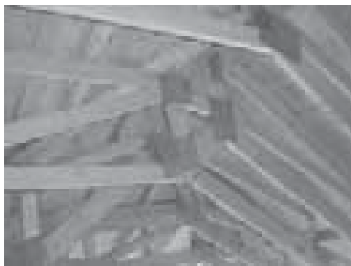
Figura 5.53_Copertura con capriate leggere collegate con piastre dentate
