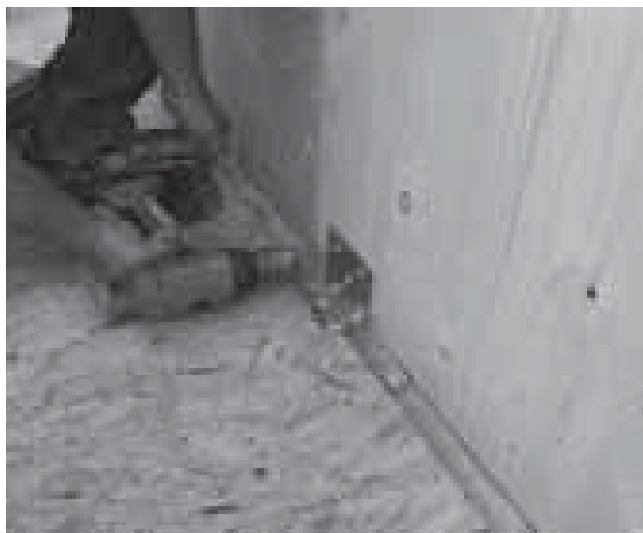
Figura 5.44_Collegamento diretto delle pareti alla platea di fondazione. Nella foto la platea è coperta da un foglio di OSB.
