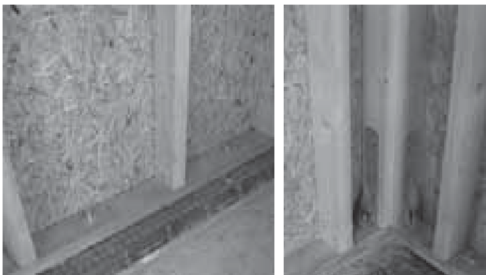
Figura 5.45 Particolare del collegamento alle fondazioni con tirafondi metallici e con hold-down in un edificio Platform.
