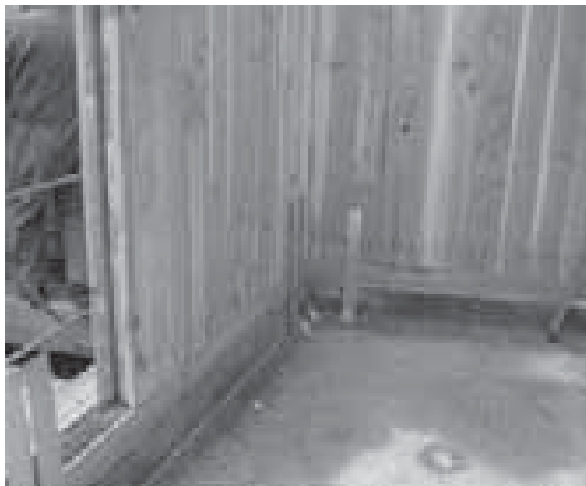
Figura 5.43_Collegamento delle pareti alle fondazioni con interposizione di cordolo in legno lamellare di larice posto sopra cordolo in calcestruzzo con interposizione di disaccoppiante acustico. Al di sotto del cordolo viene posta una guaina bituminosa che risvolta sul lato esterno.
