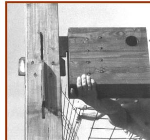
In caso di insufficienza della sezione resistente degli elementi standardizzati si ricorre all'affiancamento, anche multiplo, di altri componenti lignei simili. L'ossatura portante del sistema prevede un **intervallo di circa 40 cm** degli **elementi montanti** (facenti funzione di piedritti snelli e ravvicinati) che attraversano entrambi i solai.
