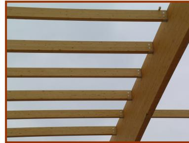
**Struttura con travi singole passanti tra montanti o in luce**
