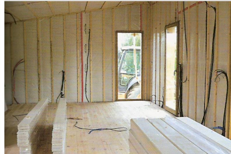
**Esempio di previsione impianti elettrici in edifici a secco in legno**
